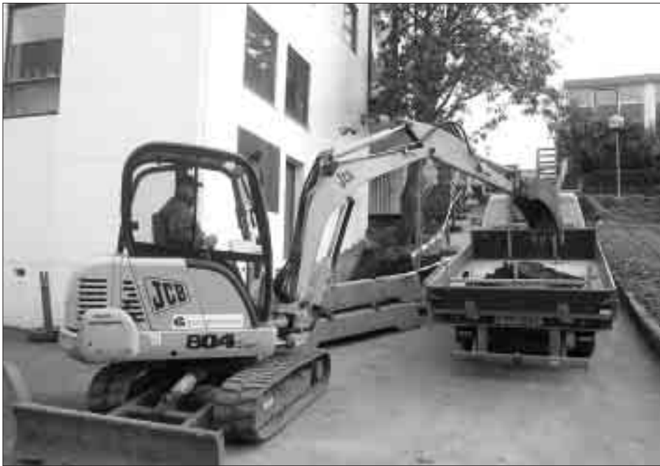
Trappurnar í gomlu posthúsbrekkuni eru burtur, tí at kloakkirnar verða skiftar út. Tá ið arbeiðið verður liðugt, kemur alt tó at líkjast sær sjálvum aftur
