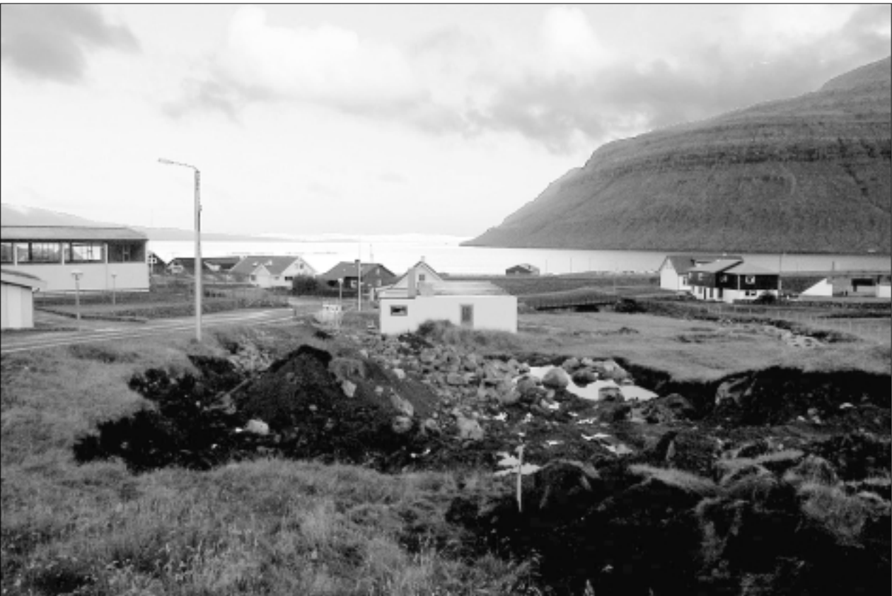
Grivið er út fyri nýggja samkomuhúsinum hjá Brøðrasamkomuni í Kollafirði
