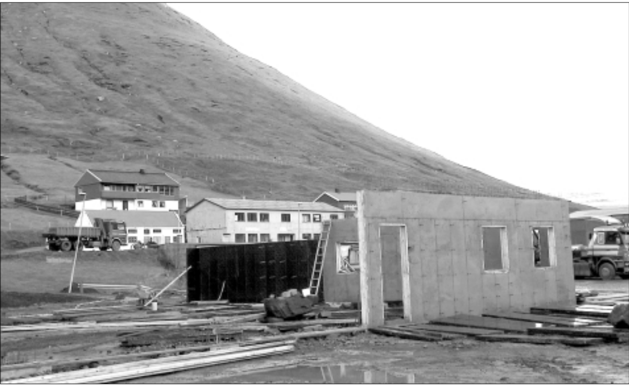
Atlantic Pane byggir nøtt termorútavirki inni á Ósábakka í Kollafirði
