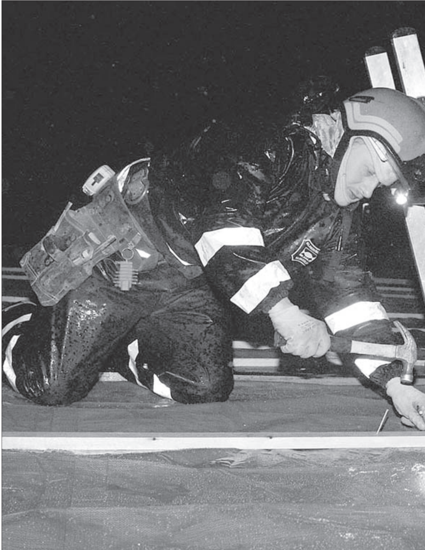
Teir arbeiða við eini húsatekju í Norðdepli, har lektirnar vóru loysnaðar. Hon fekk skaða í fyrra storminum, og var nú farin aftur at leka
