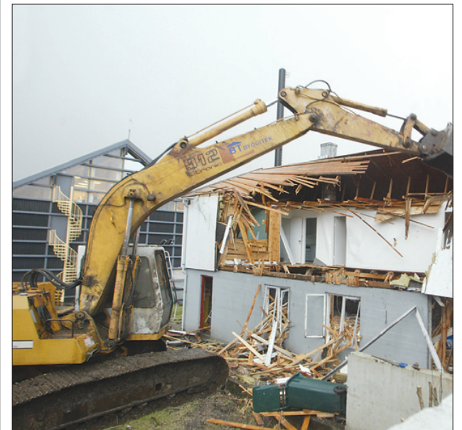
Hesi bæði húsini við Tinghúsvegin í Havn eru nú farin í søguna – og í teirra stað koma 70 nýggj parkeringspláss til SMS
