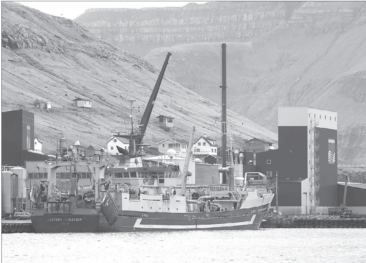
Ídnaðarvirkið Havsbrún í Fuglafirði
