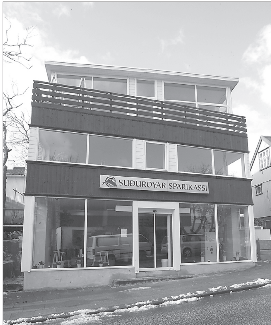
Bygningurin, har Suðuroyar Sparikassi nú húsast í ovara parti av miðbýnum, setir sín dóm á miðbýarumhvørvið
