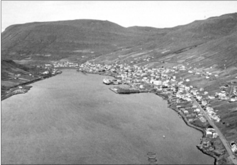
Gongst sum ætla, verur nú farið undir at byggja eitt stórt virki til uppsjóvarfisk í Vági. Virkið skal byggjast niðanfyrí frystigoymsluna og tað skal klára at frysta 500 tons um samdøguri. Á virkinum fer at vera arbeiitt í tveimum vaktum og tað verur brúk fyrí 15-18 fólkum á hvørjari vakt
