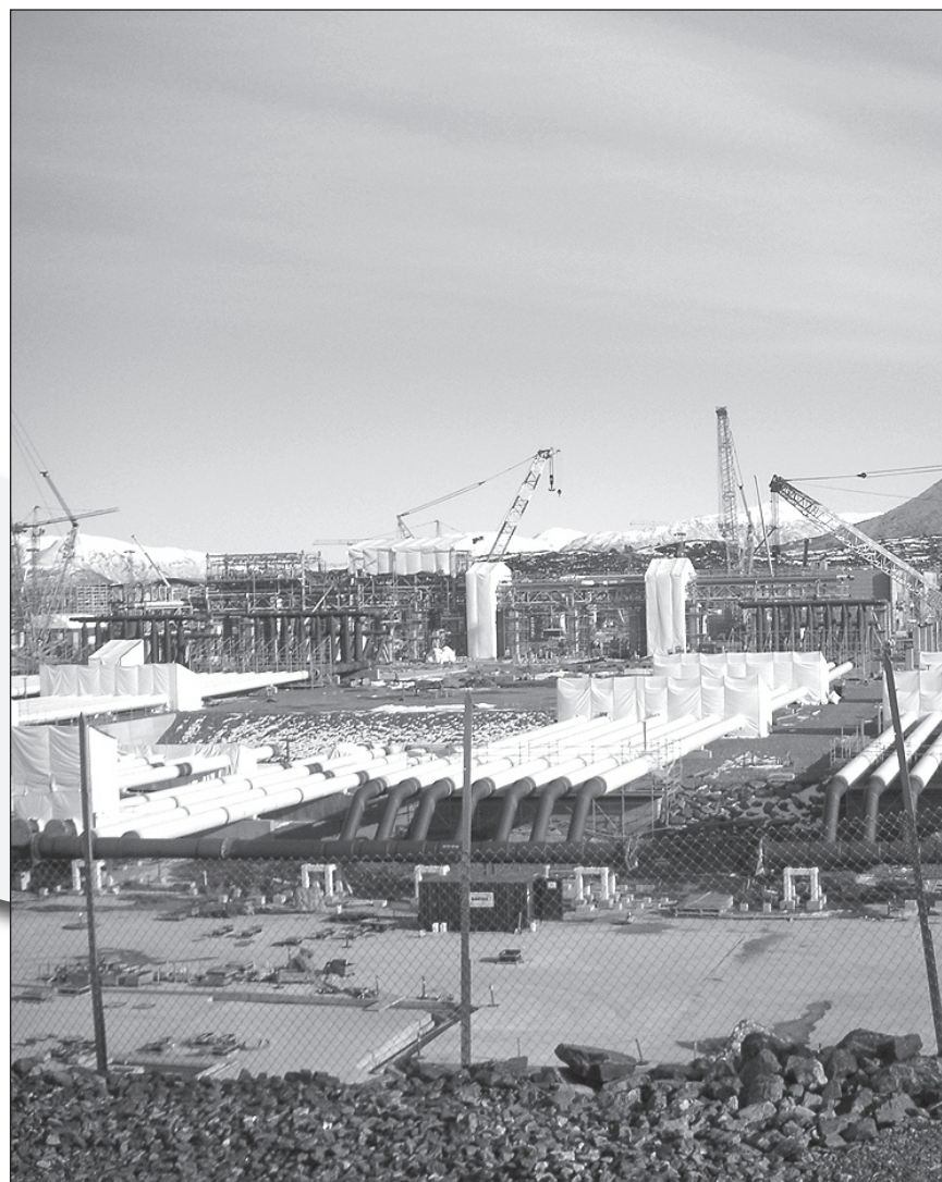
Eisini færoyingar eru við at byggja hetta risastóra gassanleggið nær Aukra í Noregi
