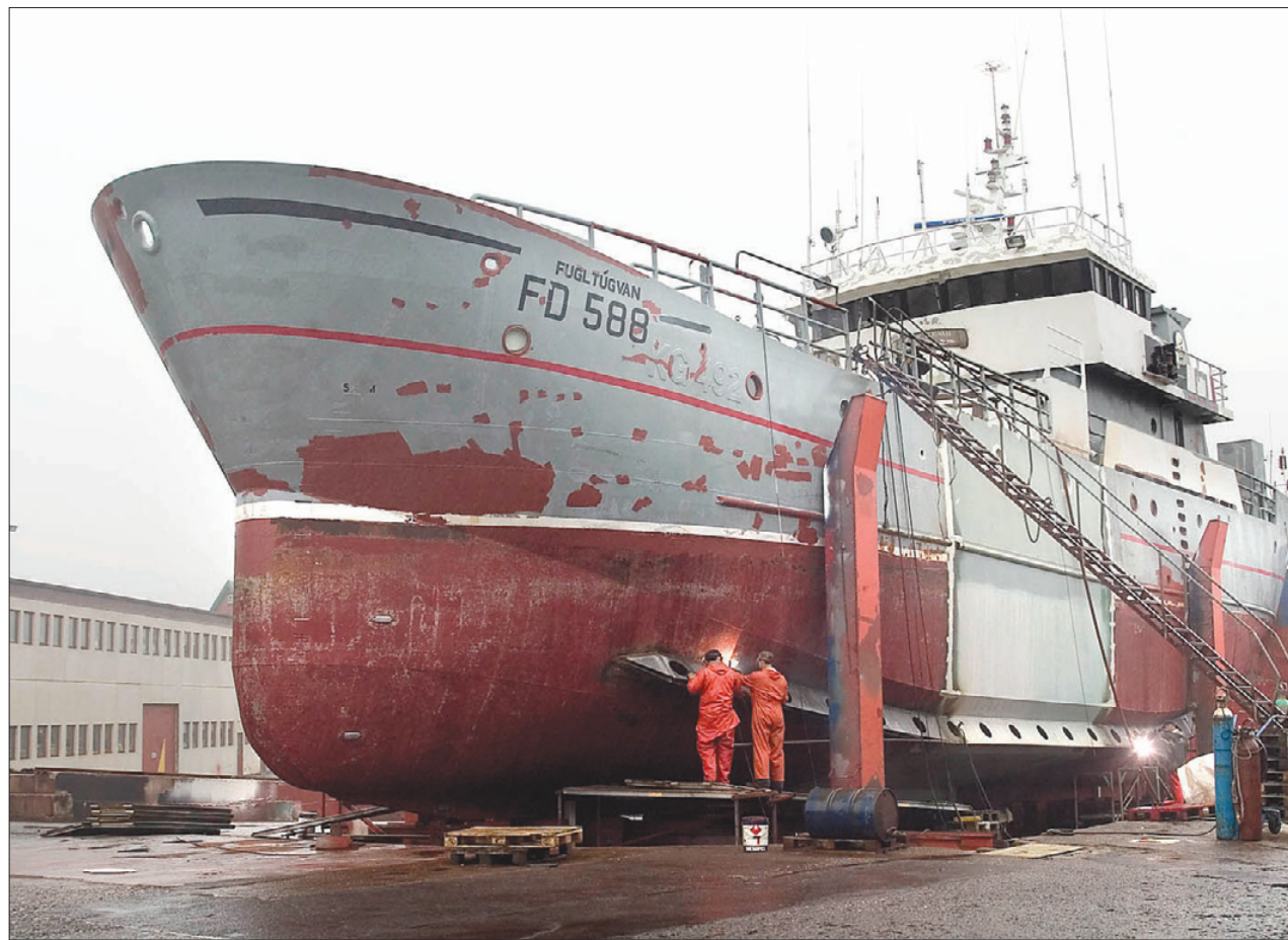
Fugltúgván verður longd við 6,60 metrum. Harafturat fær skipið nýggjar slengrikljolar og nýggjan stabiliseringstanga
