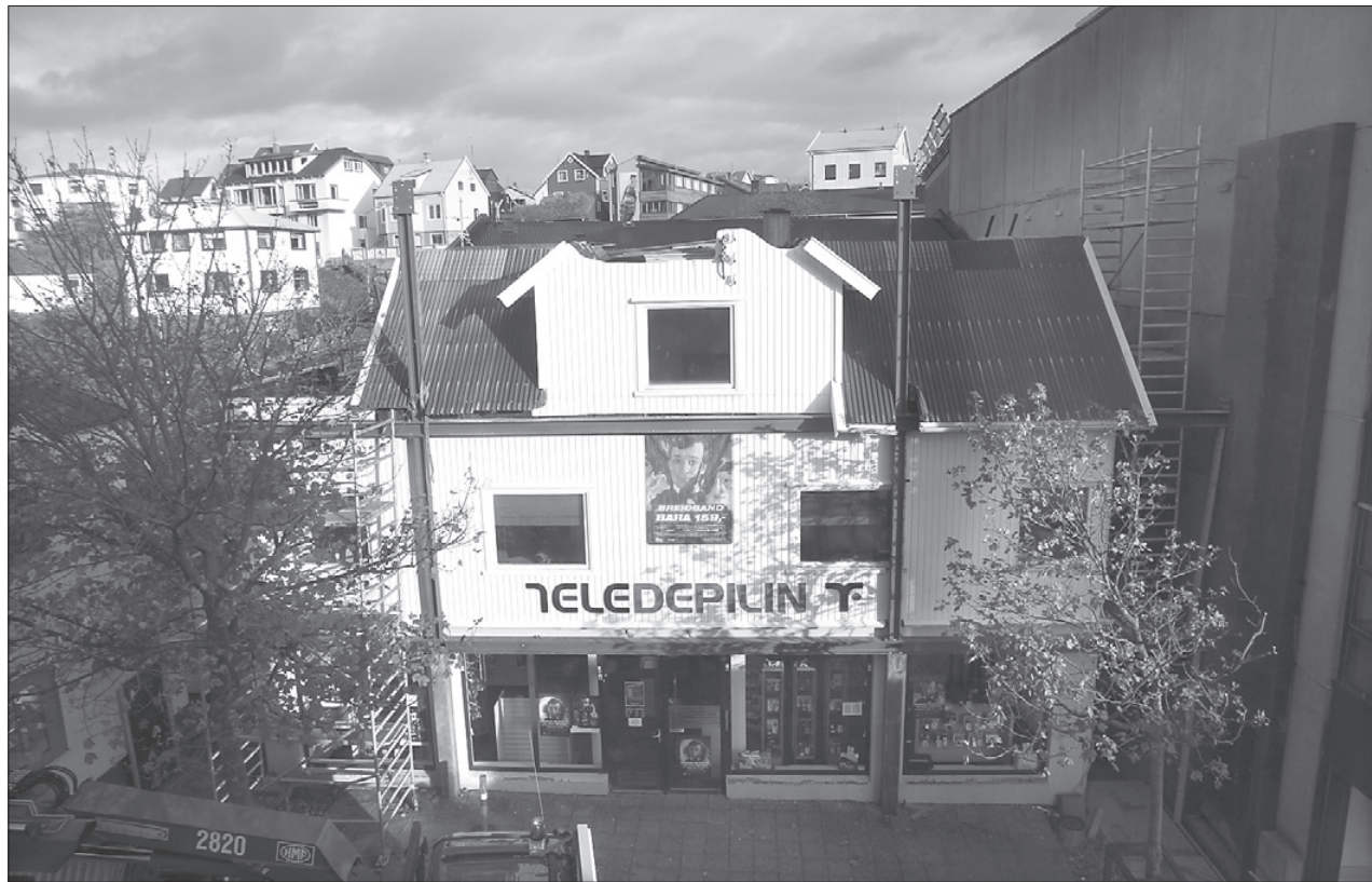
Bygningurin hjá P/F Ingibjörg Dam, har Teledepilin heldur til í N. Finsensgøtu, verður í lötuni umbygdur
