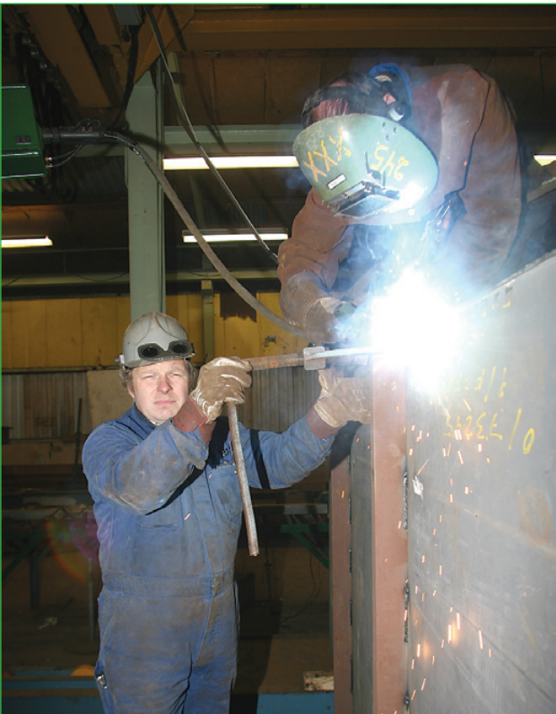
Arbeðsmenninir gera klárt inni í byggiðollini
