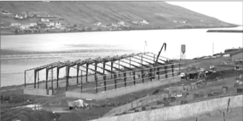
Tað er ikki á hvørjum degi, at nýggir virkisbygningar stinga seg upp í útjaðaranum. Nýggj framleiðsluhøll er reist í Vági. Tað er trollemmavirkið Injektor Door, sum við hesum sleppur úr leigaðum hølum og í egna høll
