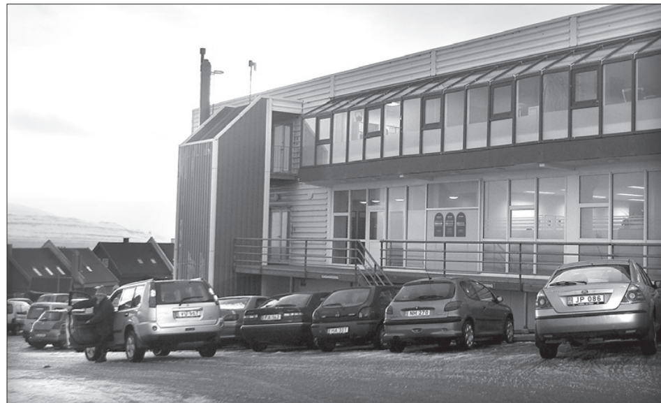
Posthúsið á Óðinshædd. Inngongd til kantinuna er við bokshurðina á norðursíðuni á bygninginum, móti parkeringsplássinum
