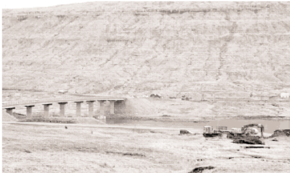
Teir grava út fyri vegi til nýggja miðstaðarøki beint norðan fyri Streym
