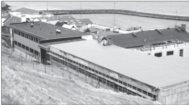
Arbeiðið er nú komið so langt, at ein rættiliga stórur partur av nýggja tilbygninginum, sum er bygdur norður úr verandi skúla, er innilokaður
