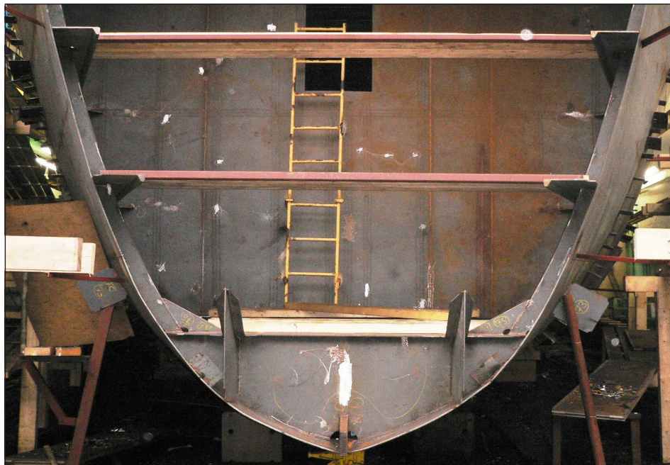
Umleið 2/3 av tí fyrri nýbygninginum á Skála eru nú komnir upp, og skjótt verður farið undir at skera stál til hin næsta nýbygningin
