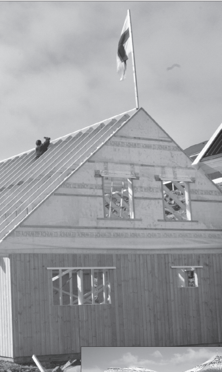
Í góðveðrinum í gjár vórðu øll trý húsini, sum AK-Byggivirki byggir á Kollshjøllum, reist Mynd: Birgir W. Høgnesen
