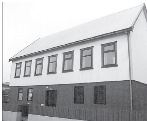
Gamla missiónshúsið á Strondum hevur verið í tænnastu í 71 ár. Nú verður arbeitt við einum nýggjum húsi
