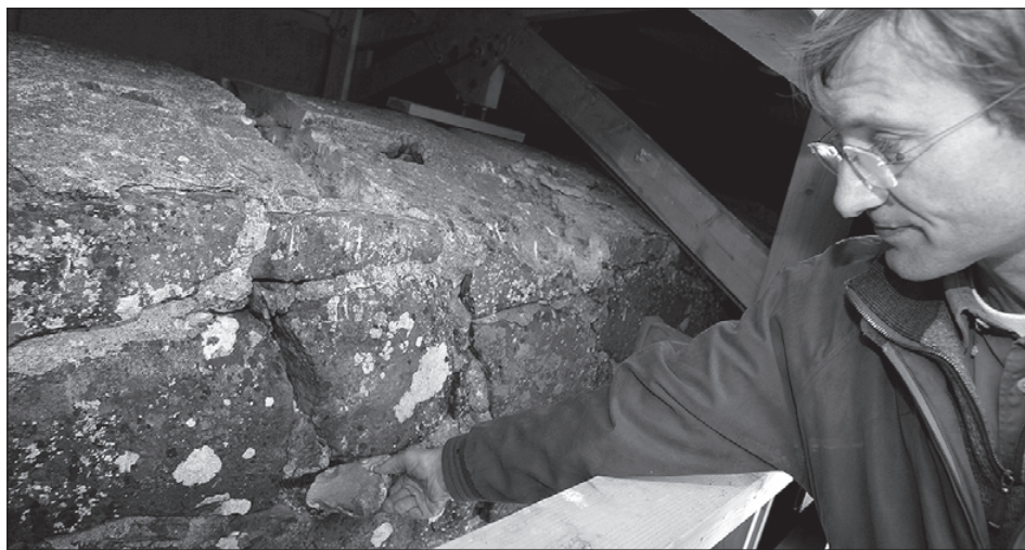
Í eitt ár hava máttitól staðið á Múrinum og skrásett til dømis miðalhitan á veggnum hvønn tíma á døgnum. Poul K. Larsen frá Nationalmuseets Bevaringsafdeling sigur, at mátingarnar vísa, at verjan ger mun, tí hon bæði turkar og stabiliserar hitan
