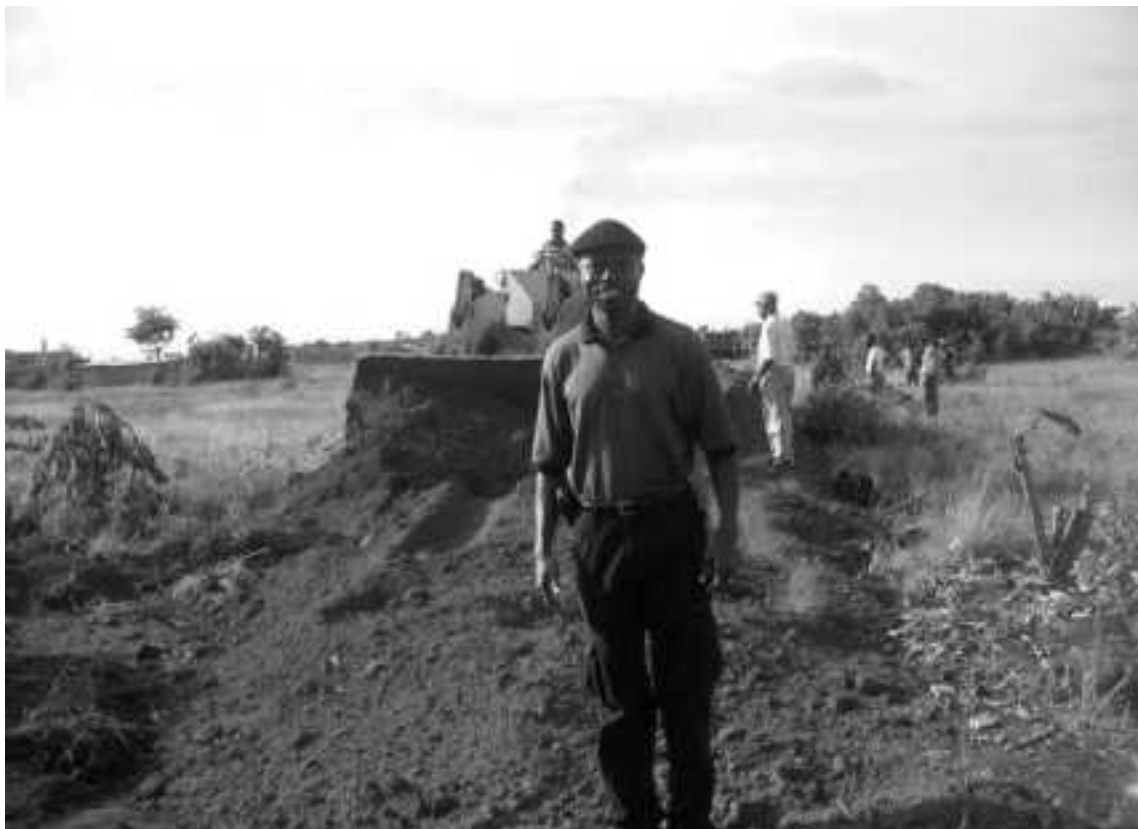
- Arbeiðsloysi í landinum er stórt og tað stendur ikki á at fáa arbeiðsmegi, sigur Matthew Zakeuh, sum nú er í ferð við at gera veg inn til skúlaøkið
