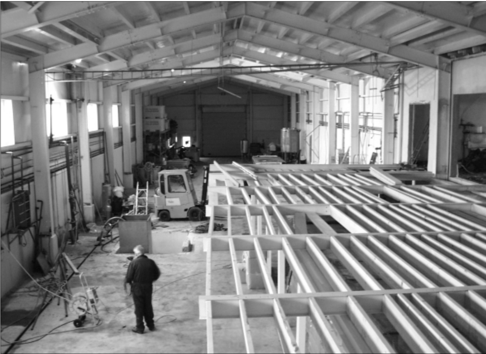
Nakað væl av umbygging skal til, aðrenn virkið er klárt at byrja
