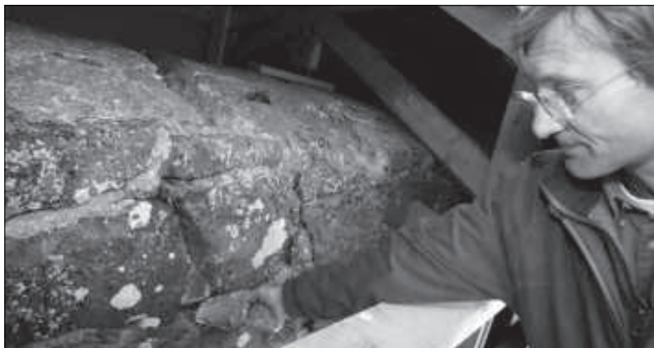
Í eitt ár hava máttól staðið á Múrinum og skrásett til dømis miðalhitan á veggnum hvønn tíma á døgnum. Poul K. Larsen frá Nationalmuseets Bevaringsafdeling sigur, at mátingarnar vísa, at verjan ger mun, tí hon bæði turkar og stabiliserar hitan
