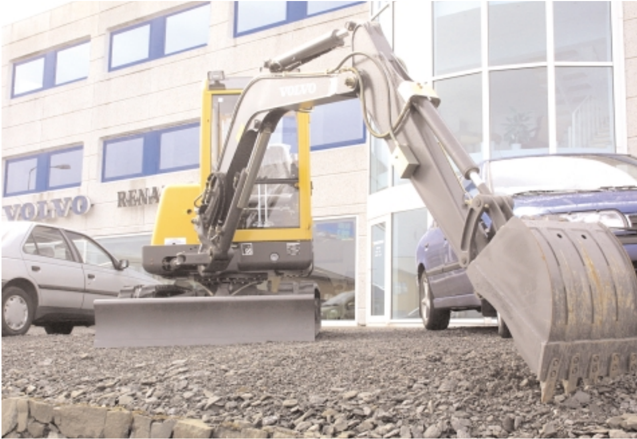
VR Bilar við Hoyvíksvegin fara nú at gera meira við ta stóru vøruskánnu av entreprenørmaskinum hjá Volvo. Á myndini er ein Volvo EC 35, ið er ein 3,5 tons veltmaskina
