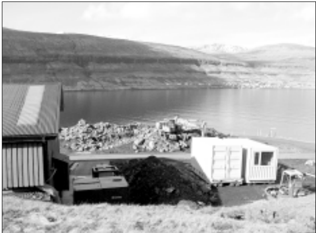
Nýtt parkeringsøki verður gjørt uttan fyri sandblásingarvirkid við Ljósá
