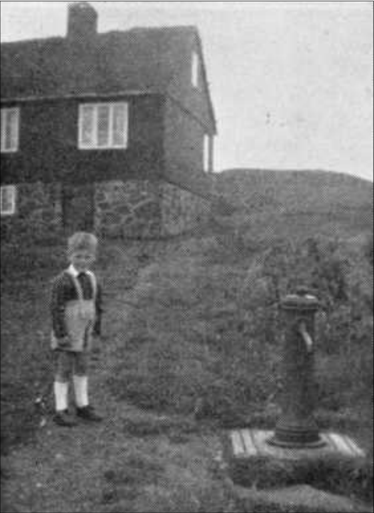
Tað gekk ein tíð áðrenn øll húsini høvdu fingið vatnið innlagt. Tí vóru vatnpostar sum hesir settir upp ymsastaðni í býnum. Hetta er tann seinasti sum stóð eftir
