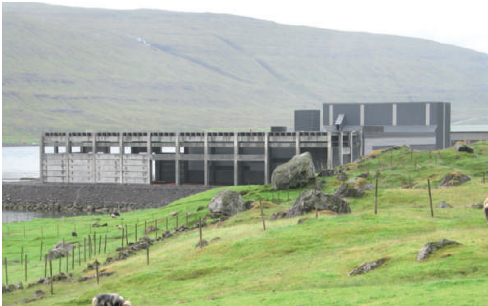
Í lötuni er Løvubetong betongblandistøð og sementheilsøla, men fyrst í komandi ári fevnir virksemini teirra ætlandi eisini um framleiðslu av betongementum
