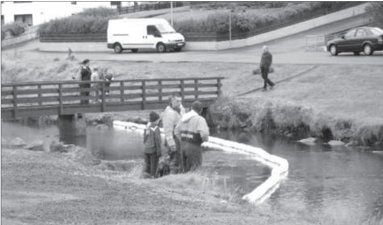
Oljusperringar eru lagdar út í Eiðisá í Norðagøtu, eftir at olja er likin úr einum ótøttum røri frá einum nýggjum sethúsum í bygdini
