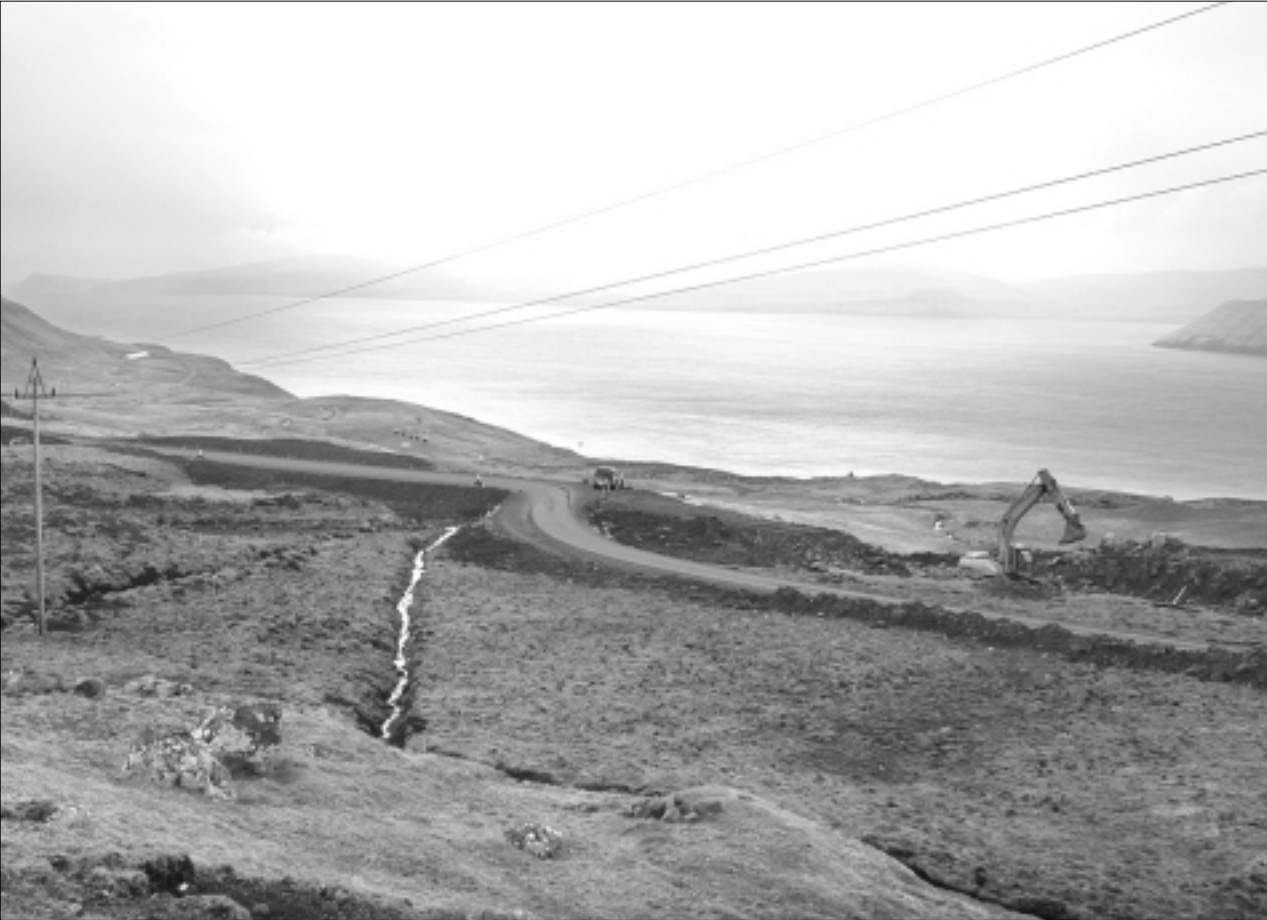
Arbeidið uppá vegin millum Gomlurætt og høvuðsstaðin hevur ligið stilt í einar tveir mánaðir. Nú fer landsverkfrøðingurin í holt við at asfaltera henda teinin, og tað verður koyrandi einaferð í summar
