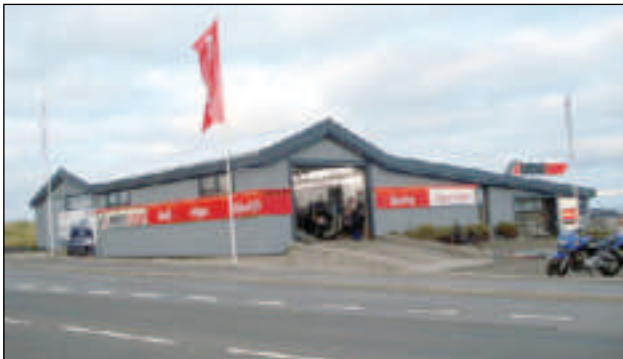
Móttøkan var í nýumvældu hølunum hjá Super Dekk við Hoyvíksvegin
