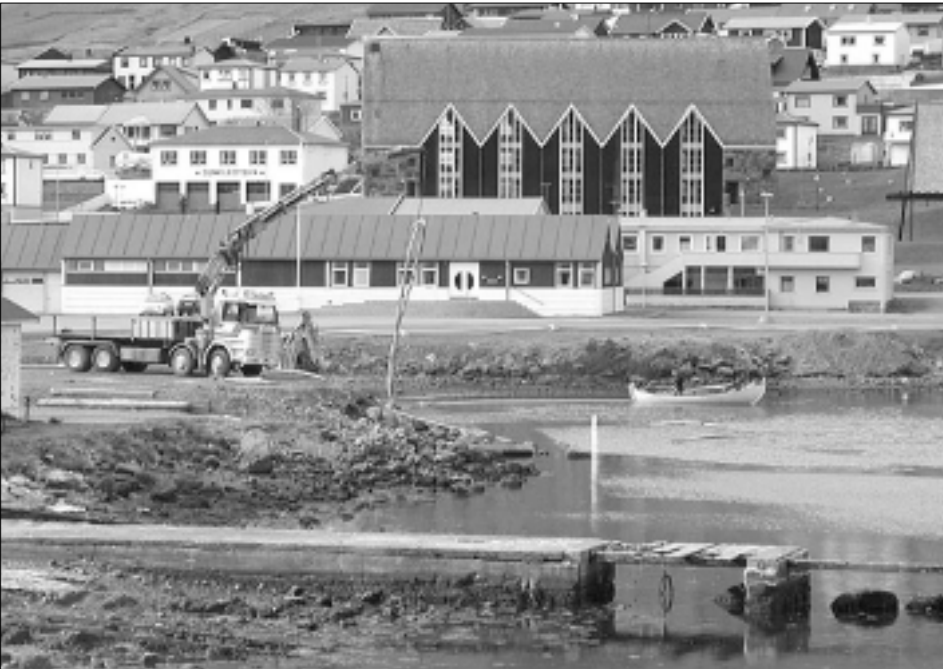
Nýggja vatnleiðingin um vágna í Klaksvík skal tryggja, at virkini á vestaru síðu fáa nóg mikið av vatni
