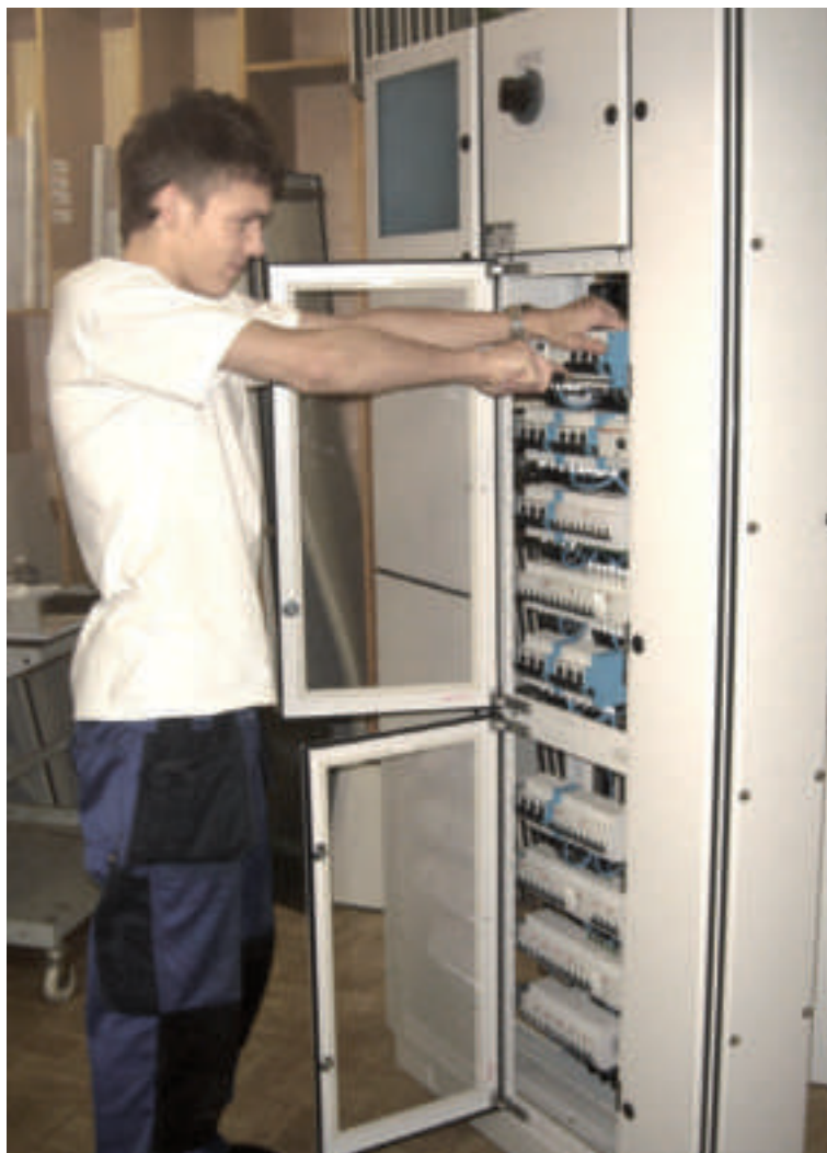
Á El-Talvuvirkinum starvast el-installatørar, elektromekanikarar, skipslektrikarar og maskinmeistarar
