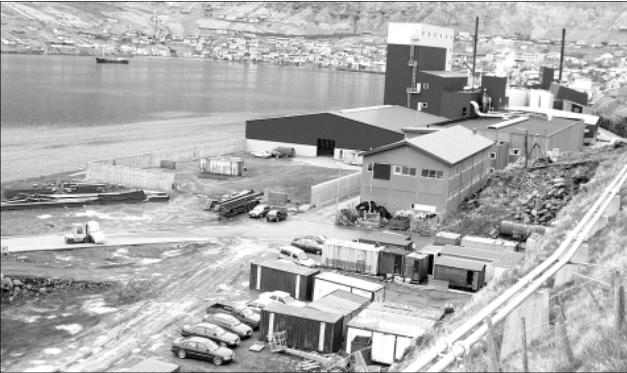
Havsbrún er farið undir árligu útyggingina, sum í ár umfatar seinasta part av goymslubygninginum
