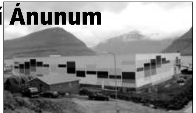
Nýggja goymslan tekur seg væl út í Ánunum, og tað er ikki sørt, at hon frískar økið upp
