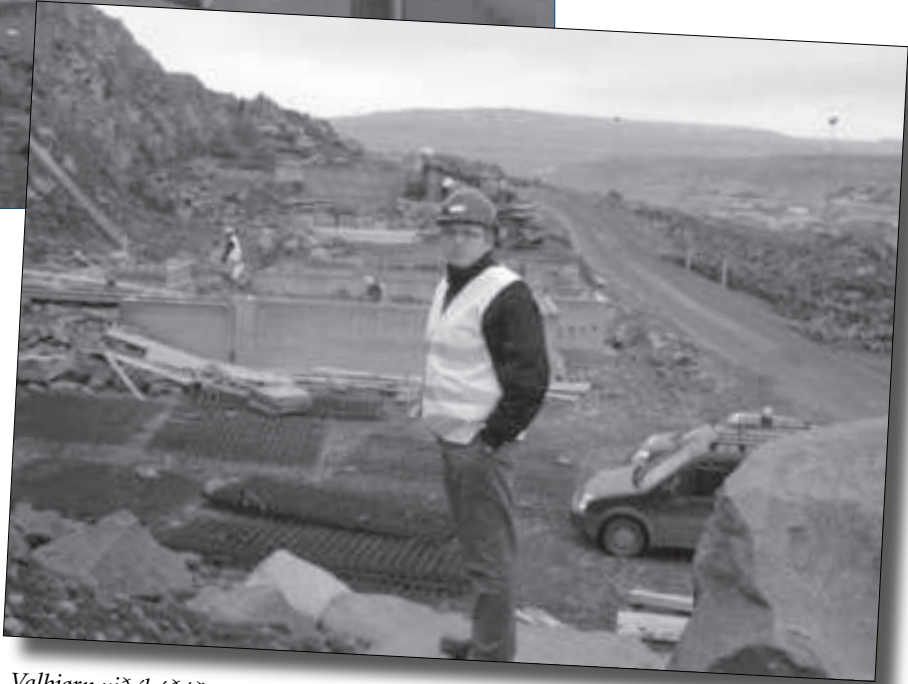
Valbjørn við íbúðunum í baksýni. Í lötuni arbeiða 38 mans upp fyrsta byggistig av trimum, sum tilsamans fer at kosta hálva milliard
