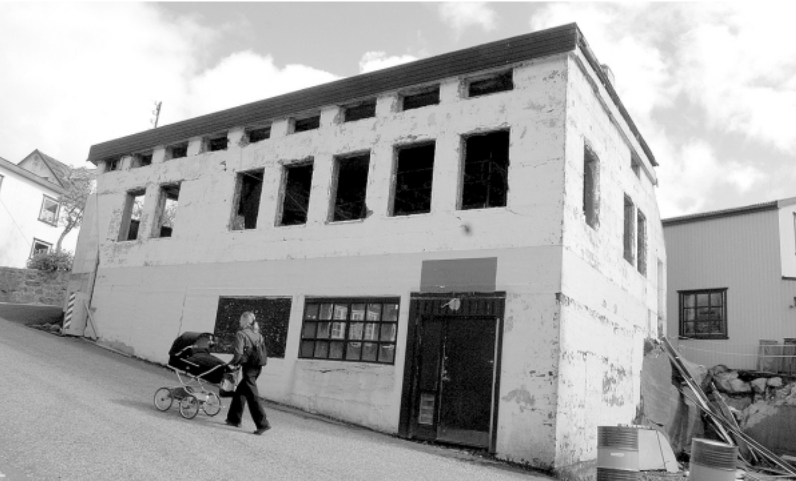
Bygningurin, har Kvøldlot helt til, hevur leingi staðið heldur óvakur mitt í býnum. Nú sleppur eigarin væntandi í gongd við at gera matstovu og dansihøli í bygninginum
