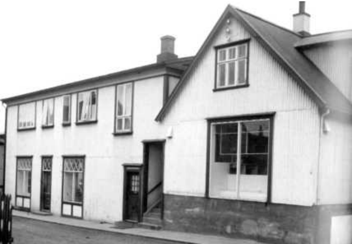
Smæran var ein av størstu handlunum í Havn, tá ið Johan var ørindadrongur, og bar vøruna út í leypu
