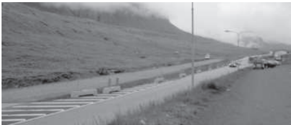
Arbeiðið at byggja rundkoyring í Gøtudali er byrjað, og ætlandi stendur Føroya størsta rundkoyring klár at taka í nýtslu á ólavseekutið
