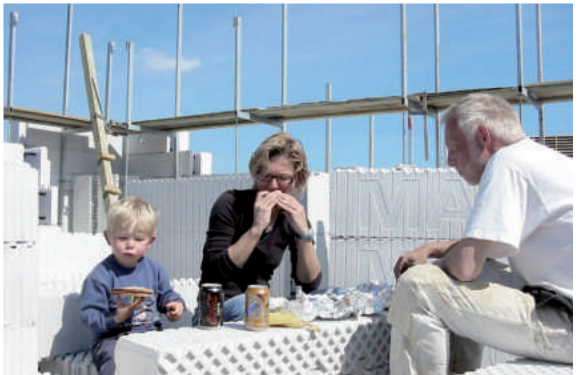
Eitt danskt par vísir á heimasíðu, www.flamingohuset.dk hvussu lætt og skjótt tað er at byggja eini hús við Magu byggiskipanin
