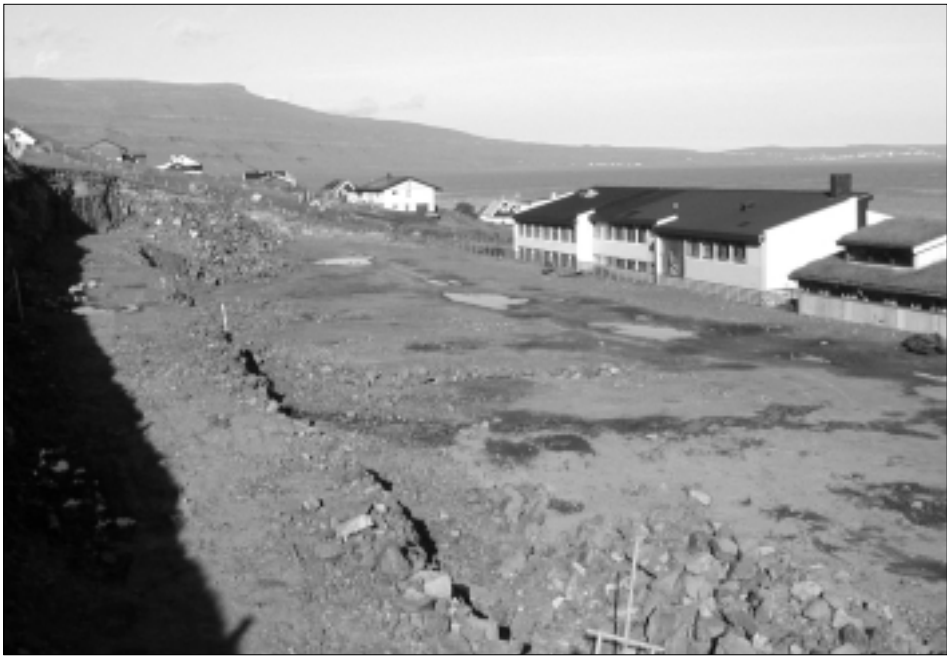
Kollfirðingar eru ørkymlaðir, nú arbeiðið við ítróttarhøllini er steðgað upp. Sambært trivnaðarstjóranum í Tórshavnar kommunu verður nýggj bygginevnd sett í næstur
