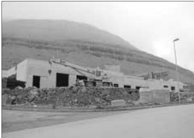
Byggingin undir Kráarbrekku er sprottin úr einum vala arbeiðið, har ein arbeiðsbólkur legði lunnar undir hesa nýbygging, og er hetta fyrsta av sínum slag í Føroyum, sigur Jógvan við Keldu
