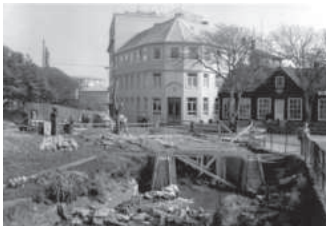
Havnará fer undir heilt. Hetta arbeiðið varð gjørt liðugt í 1957, og samstundis varð vegurin breiðkaður
