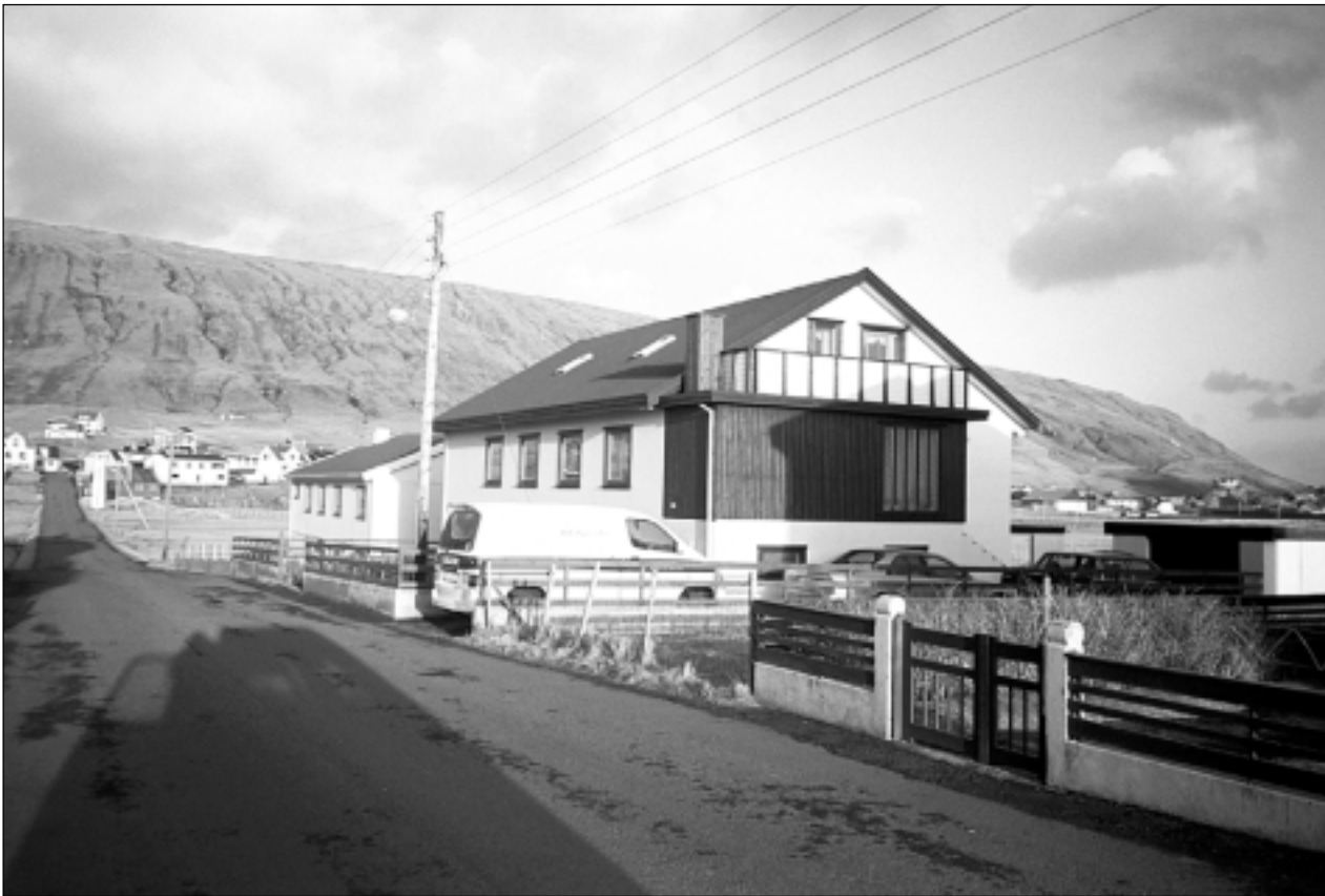
Hesi húsini í Hvalba hevur kommunan keypt til eitt eldrasambýli og miðað verður eftir, at tað skal verða liðugt tíðliga í summer. Kommunan hevur leingi arbeitt við ætlanini, men nú er so komið undir land.
