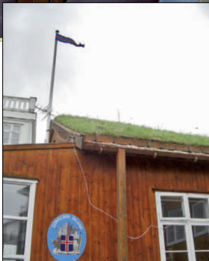
Fyri at fáa fatur á sjónvarpsmyndunum varð ein antenna stripsað fast á flaggstongina við Fútastovu
