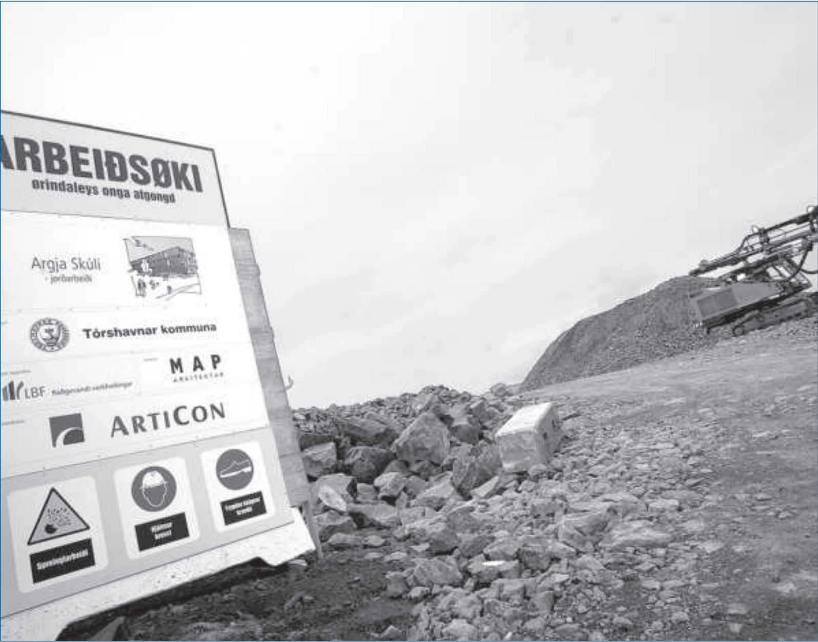
Eftir spreingiðhappið á Argjum herfyri, hevur Articon hækkað verjugarðin og dekkar nú út yvir spreingjarnar
