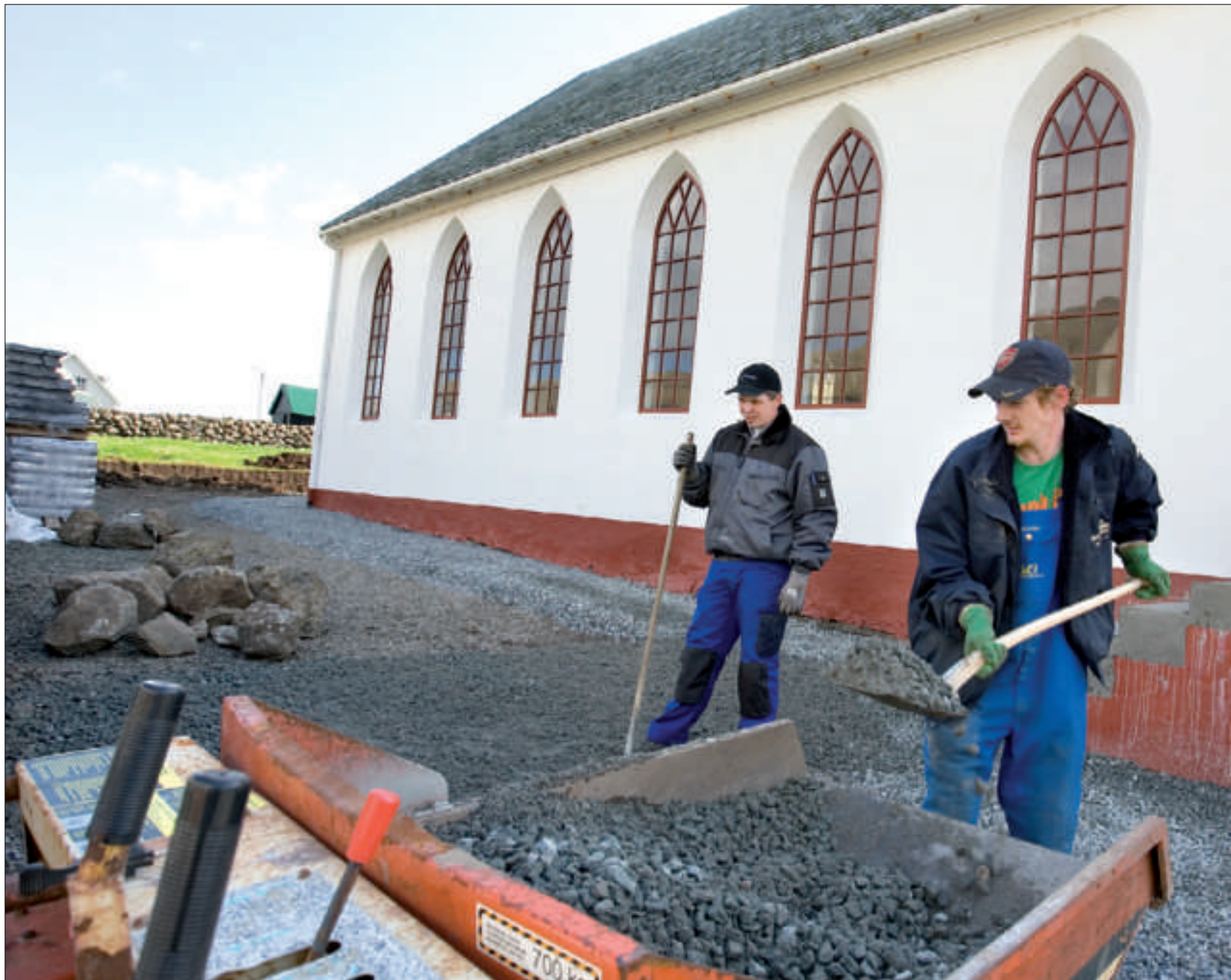
Teir stríðast óført við at gera arbeiðið liðugt, uttan tó at slakað verður uppá dygdina í arbeiðinum við at fríðka rundan um Viðareidis kirkju
