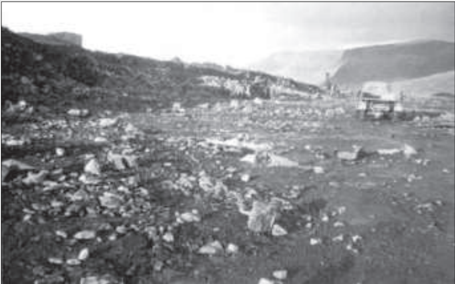
Hetta er ein partur av vestara enda á flogvøllinum undir bygging
