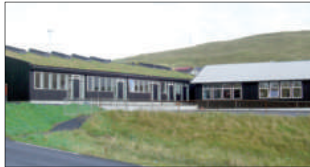
Nýggi bygningurin, sum sæst til vinstru, er nú tikin í brúk, meðan gamli bygningurin, til høgru, verður umvældur
