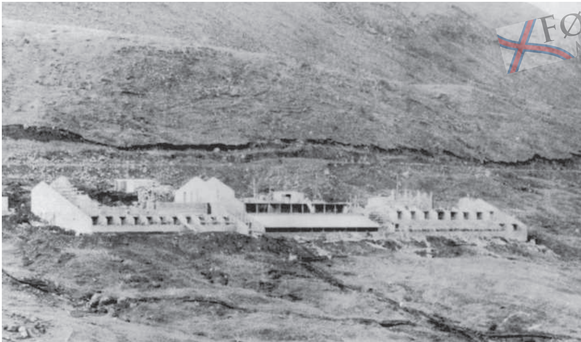
Bygningurin í Mjorkadali í gerð. Oman fyri bygningin sæst Oyggjarvegurin, sum verður gjørdur samstundis. Lønarstríð tók seg upp millum ein av donsku arbeiðstakarunum og arbeiðsmannafelagið í Kaldbak, meðan húsið varð bygt. Myndaeigari: Georg Sylvest Pedersen
