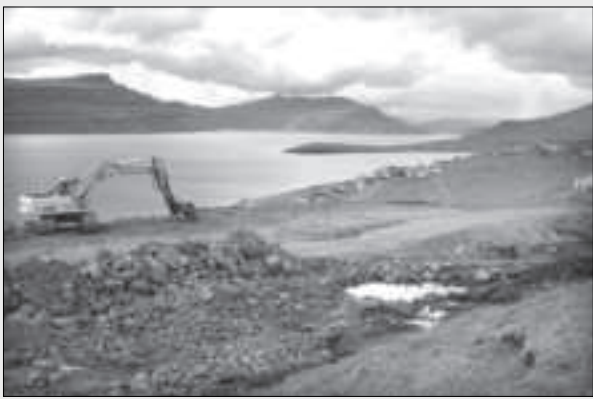
Tað er her uppi á Gadd á Nesi í Eysturoy, at Blái Krossur skal byggja nýtt viðgerðarheim. Útsýnið er eitt tað besta í øllum landinum, har bæði sæst í ein norðan, vestan og ein sunnan
